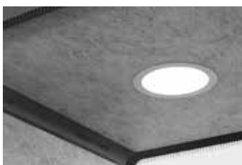
BEÉPÍTETT VILÁGÍTÁS: biztosítja a kabin fényellátását
